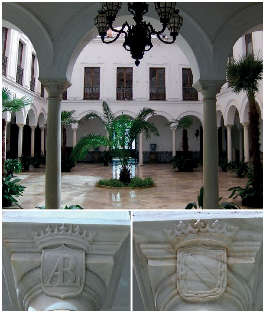
Patio y detalles de capiteles. Palacio Villamanrique de Zúñiga
