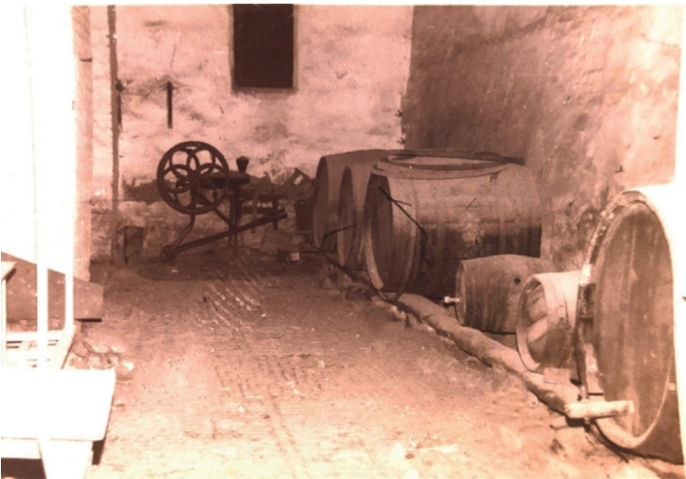
Fotografía retrospectiva de 1967-68 de una parte del Colmao antes de su última restauración. Los arcos están enlucidos y encalados.
